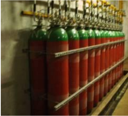
Resim 7 Elektrik ve UPS Odası Yangın
