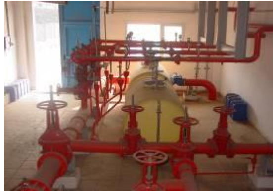
Resim 10 Yakıt tankları için köpüklü yangın
