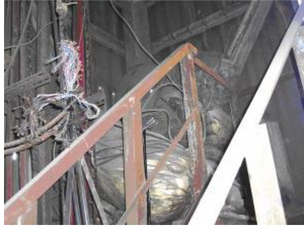
Resim 4a Kablo tüneline enerji kabloları arasında yanıcı atık maddeler
