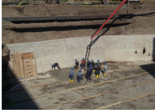
Örnek 4 ; Emniyetli çalışma . (Alt Yapı –Kazı Çalışmaları.) Toprak kaymasının önlenmesi ve olası bir göçük tehlikesinin bertaraf edilmesi için kazı alanı çevresinde perde duvar oluşturularak emniyetli çalışma ortamı sağlanması. ( İsdemir 2008 )
