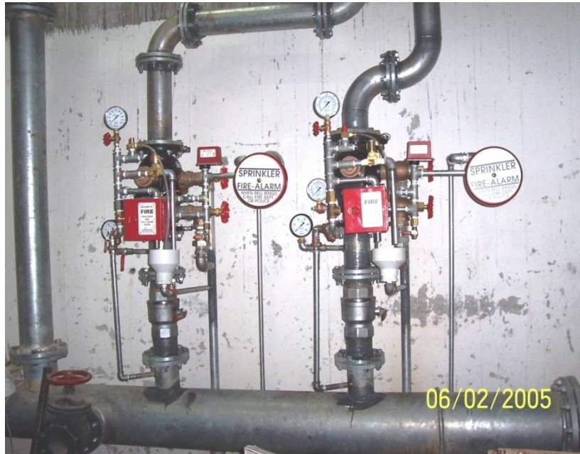
Fotoğraf 7 – Yağmurlama Sistemi Islak Alarm Vana Grupları
