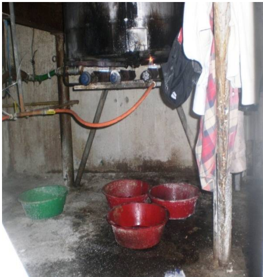
Fotoğraf 1 - Kimya Fabrikasında Meydana Gelen Bir Patlama Sonrası
