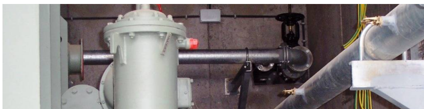
Fotoğraf 7 – Yağmurlama Sistemi Islak Alarm Vana Grupları
