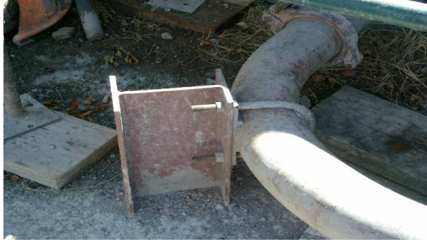
Şekil1: Beton boru hattının ankrajı için bir yöntem
